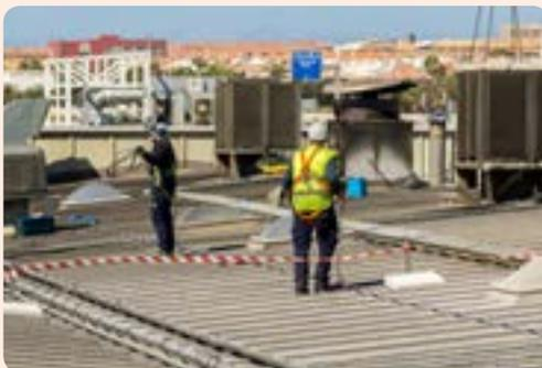
IMAGEN 11. Trabajos con riesgo de caída de altura que requiere la presencia de recurso preventivo
